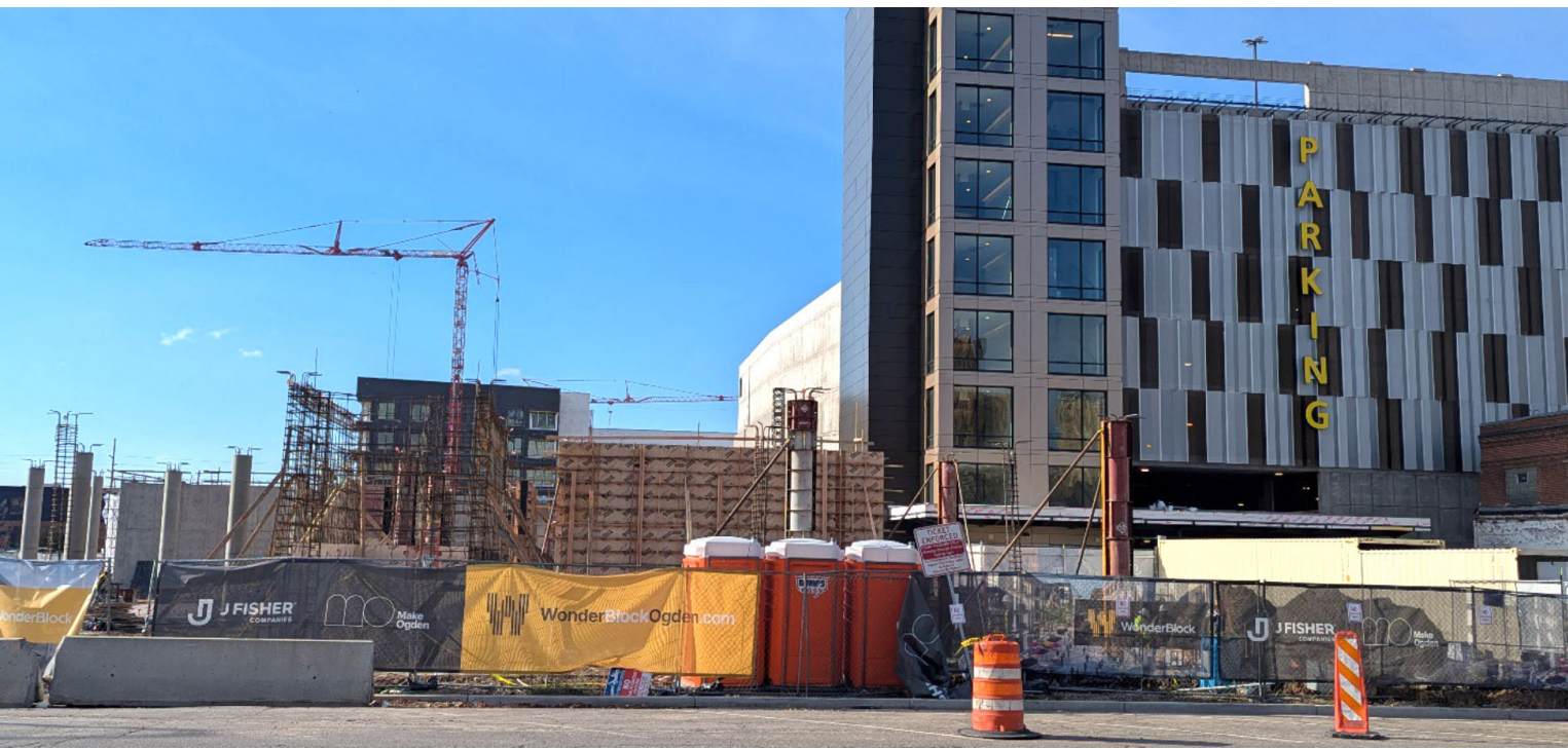
WonderBlock en la esquina de Grant Ave. y la calle 26.
